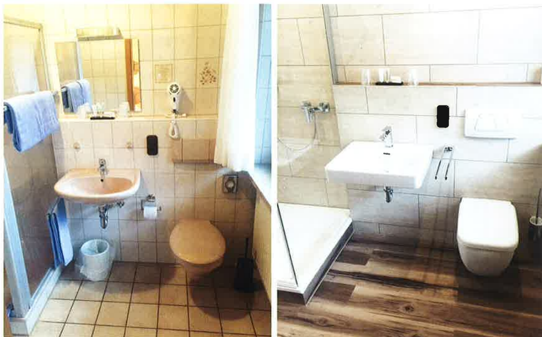
Vorher und nachher: Die Firma B.O.T. /// Bad Oberflächen Technik Gabriel hat ein System entwickelt, das LVT an die Wand und ins Bad bringt. Als Partner von Project Floors nutzt das Unternehmen dafür eine eigene LVT-Sonderkollektion.
