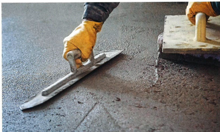
Der schwindarme Schnellzementestrich „Uzin SC 980“ trocknet absolut planmäßig, sodass die Designplanken in heller Eichenoptik zügig verlegt werden konnten.
