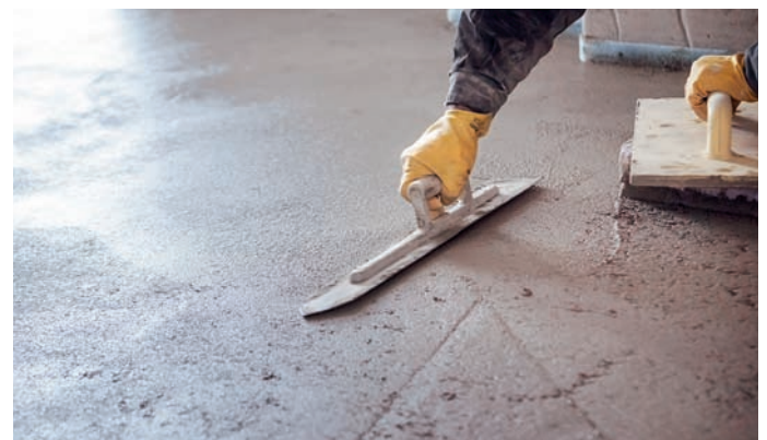
Der schwindarme Schnellzementestrich »Uzin SC 980« trocknet absolut planmäßig, sodass der Bodenbelag zügig verlegt werden konnte.
