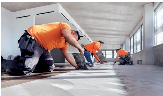
Die Vinylplanken von Project Floors wurden mit dem faserarmierten Dispersionsklebstoff »Uzin KE 66« verlegt. Seine hohe Scherfestigkeit sorgt für eine maßstabile Klebung und eine schnelle Anwendung. Foto: Günther Bayerl
