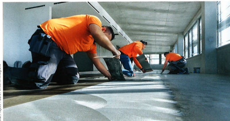
Foto: Project Floors / Kriecher fotografie
