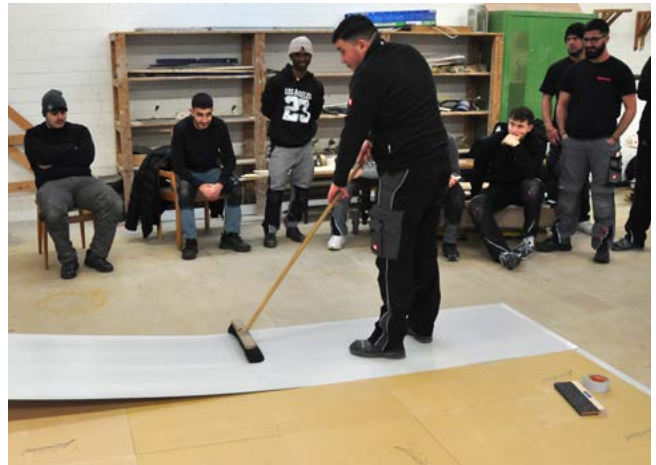
Die Schüler lernten den Umgang mit dem Uzin-Trockenklebstoff Switch Tec und dem Unterbodensystem Jumpax von Unifloor.
